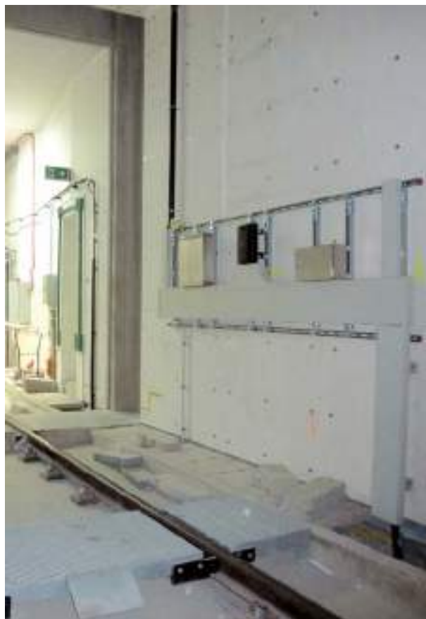
Infraestructura ferroviaria: túnel
