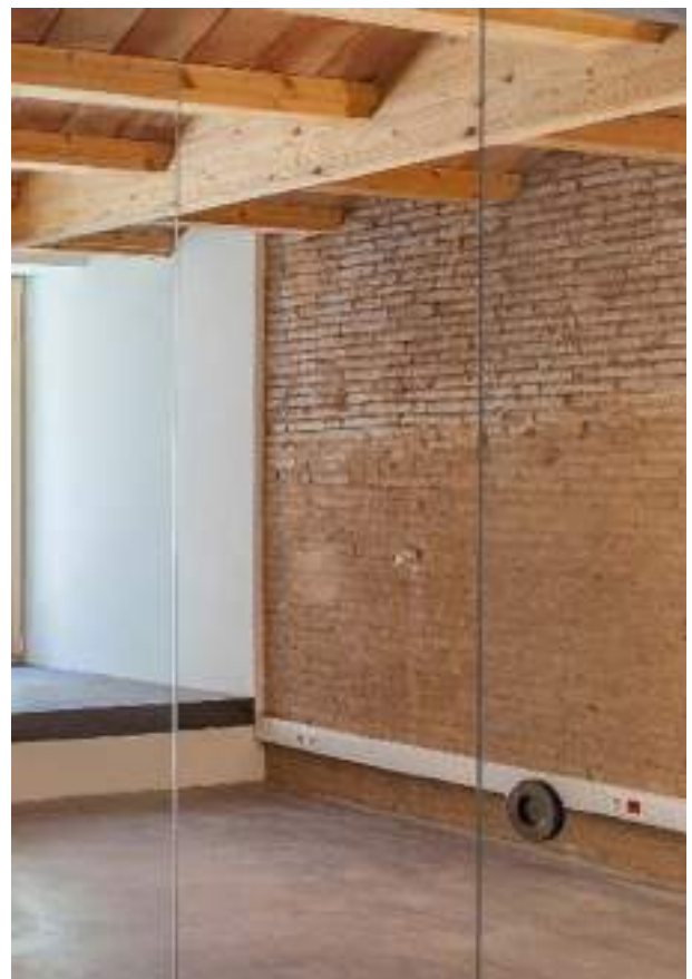
Espacios de trabajo: rehabilitación de oficina
