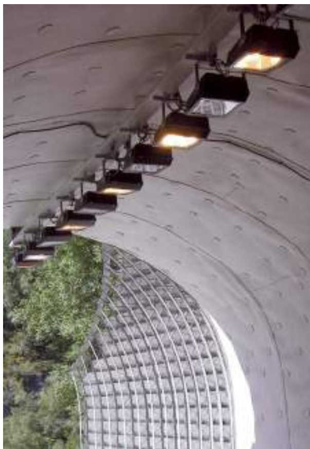
Infraestructura viaria: túnel
