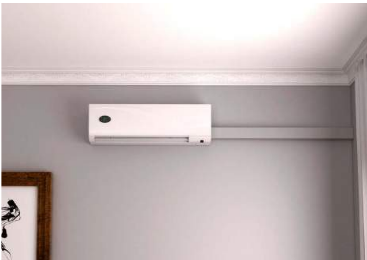
Rehabilitación de viviendas
