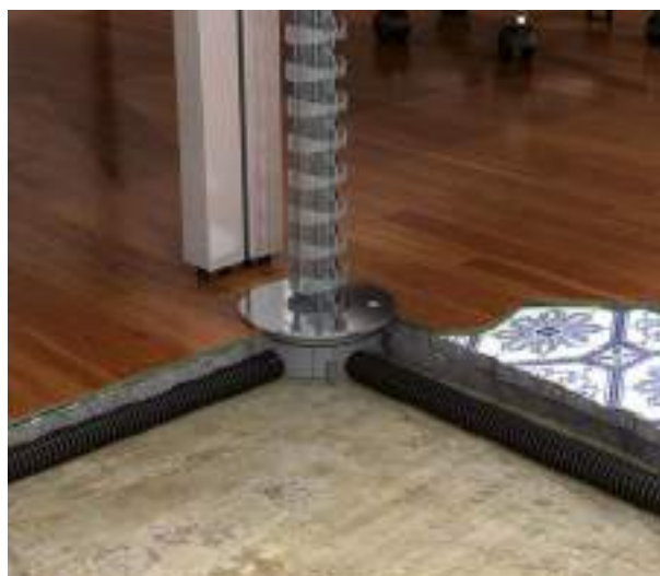
Alimentación en suelo de rehabilitación
