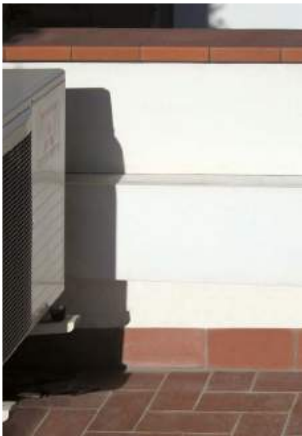
Rehabilitación de viviendas
