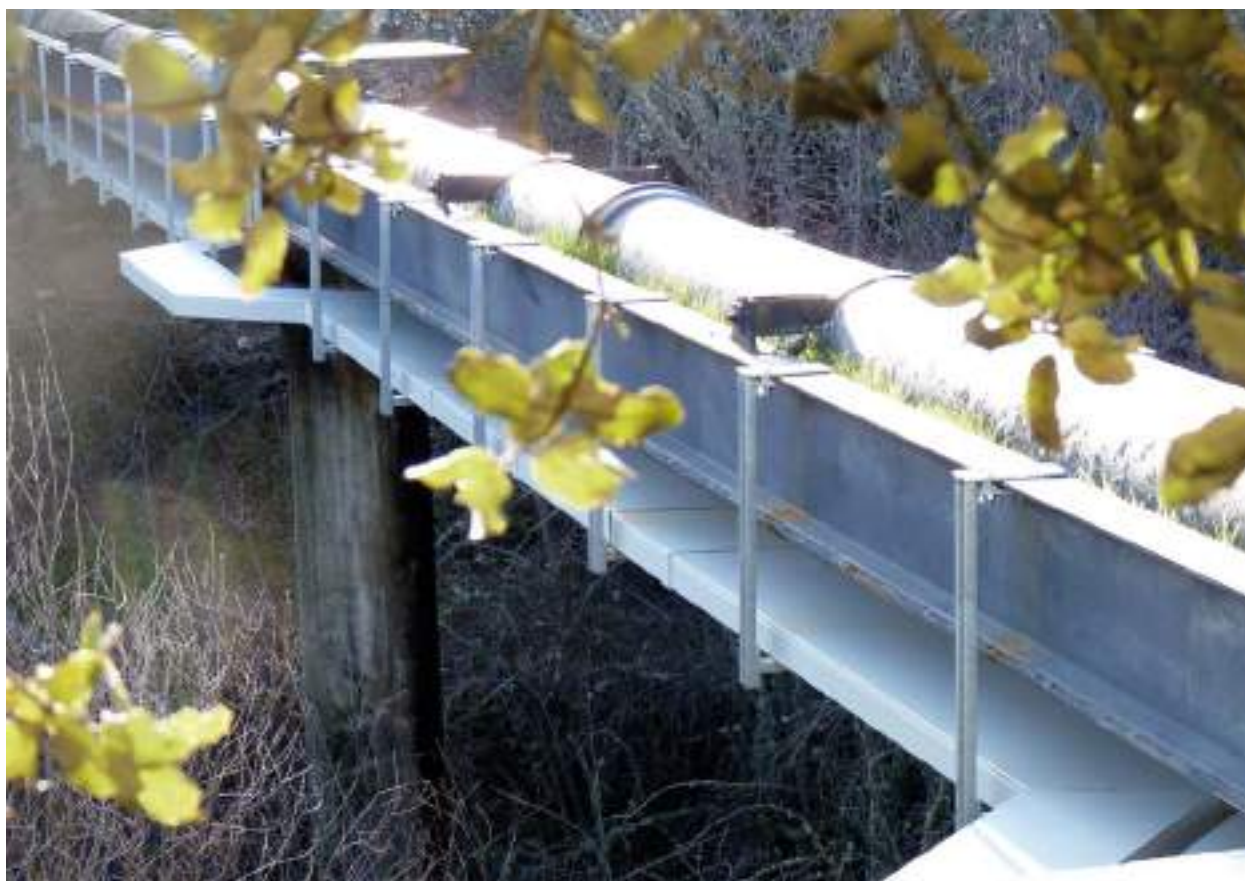
Producción y distribución de energía eléctrica
