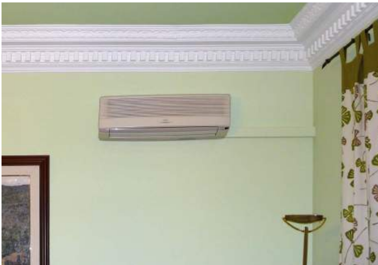
Rehabilitación de viviendas
