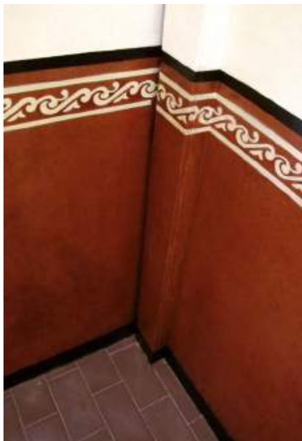
Rehabilitación de viviendas
