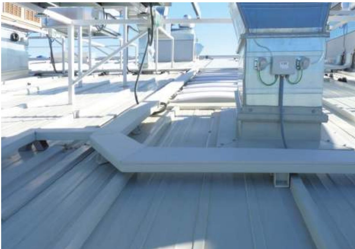
Energía fotovoltaica: depósito de autobuses
