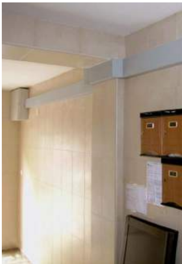
Rehabilitación de viviendas
