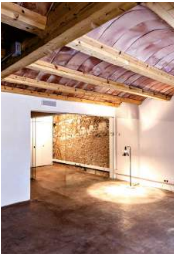
Espacios de trabajo: rehabilitación de oficina
