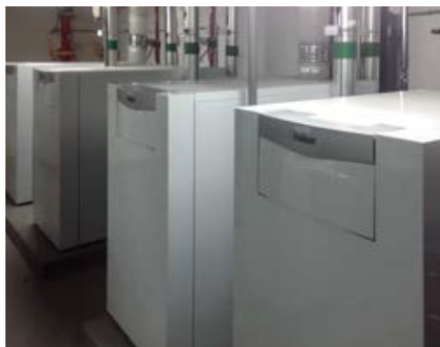
Sala de calderas con cascada de calderas ecoCRAFT exclusiv en Colegio mayor Pío XII (Madrid).
