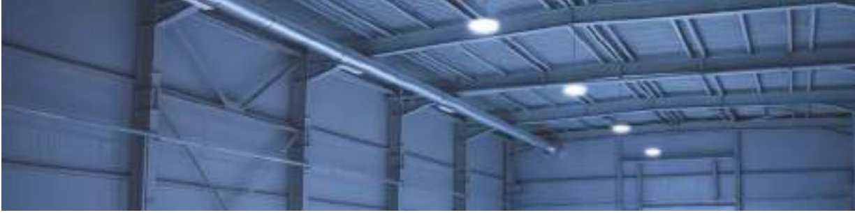
Iluminación industrial Industrial lighting
