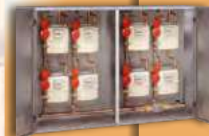
Ejemplo: Armario con batería 2+2+2+2
