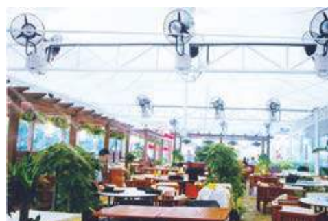
Instalación de Ventiladores murales de FresVent
