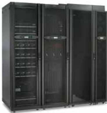
InfraStruxure para centros de datos de pequeñas dimensiones (3-20 racks)
